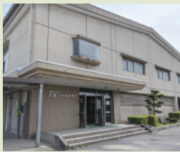
▲市橋小学校 体育館
