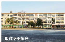
旧徹明小学校舎
